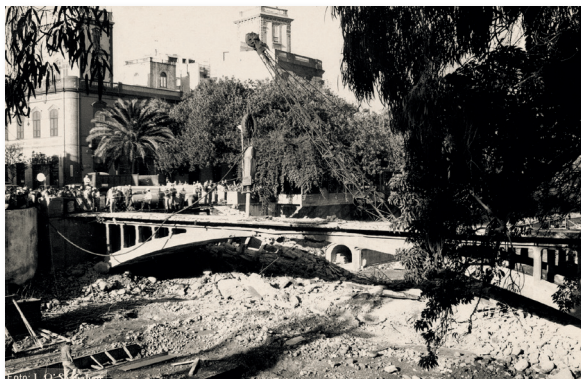
Destrucción del barranco Guiniguada ARCHIVO FOTOGRÁFICO JAIME O'SHANAHAN
