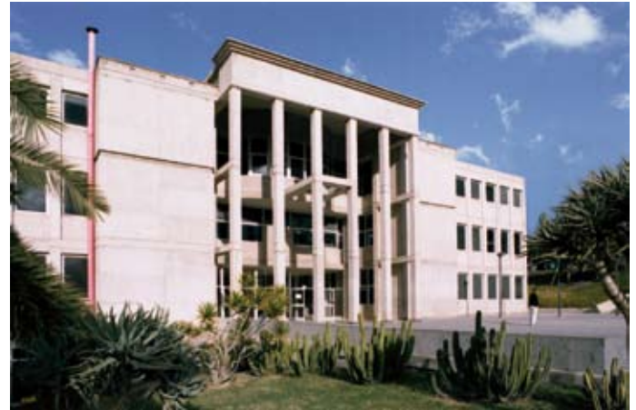
Fachada del Edificio de Arquitectura
