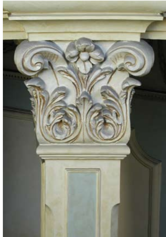
Detalle de columna en la Sede Institucional de la ULPGC
