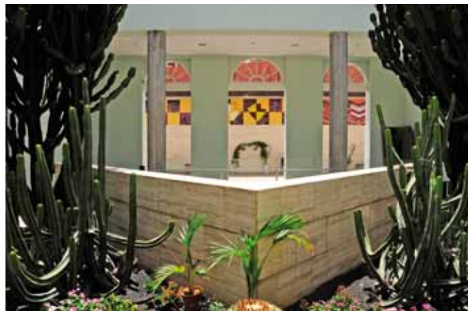
Patio de la Sede Institucional de la ULPGC
