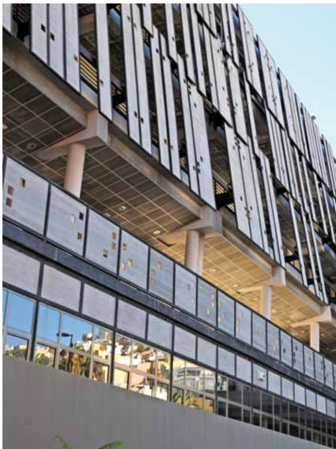
Lateral del Edificio de Servicios Administrativos
