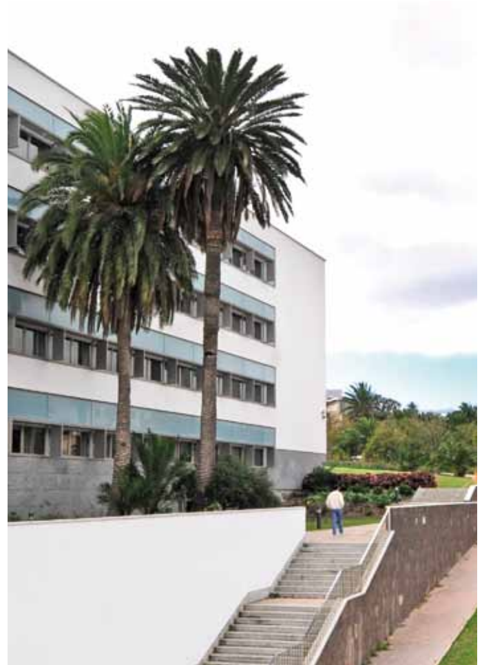
Trasera del Edificio del Aulario en el Campus Universitario de Tafira
