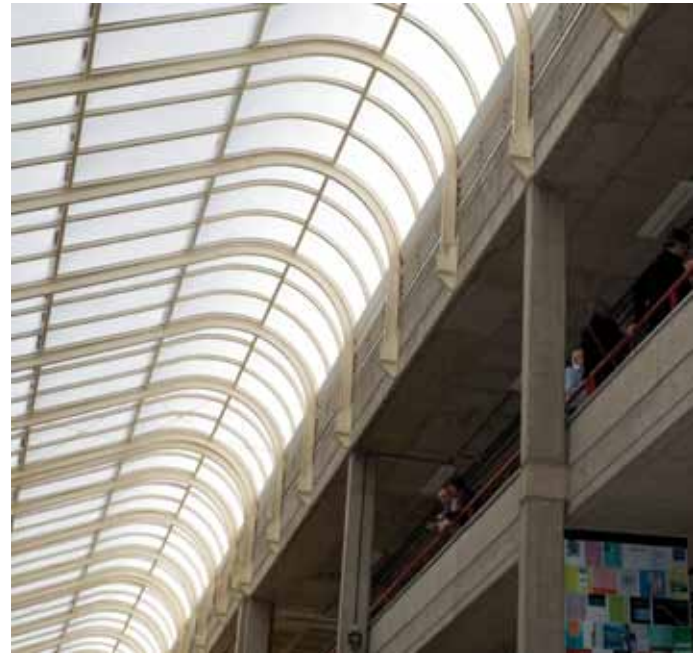
Edificio de Arquitectura en el Campus Universitario de Tafira
