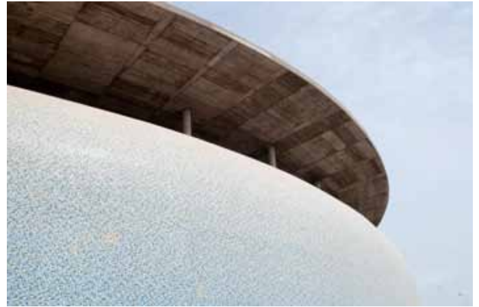
Detalle del Edificio del Centro de Biotecnología Marina en Taliarte
