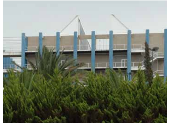
Detalle del Edificio de Ciencias Básicas
