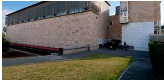
Ampliación del Edificio Central de la Biblioteca General
