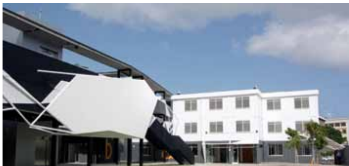
ESTRUCTURA DE TELEFORMACIÓN ULPGC
