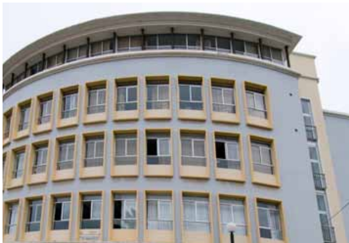
Fachada del Edificio de Formación del Profesorado
