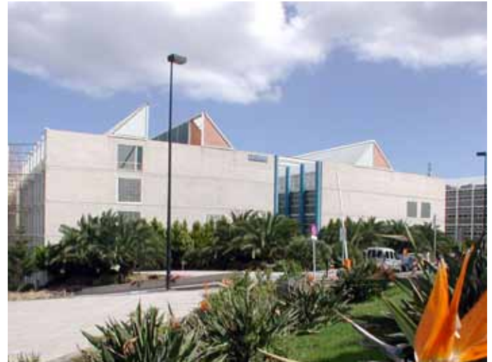
Edificio de Ciencias Básicas
