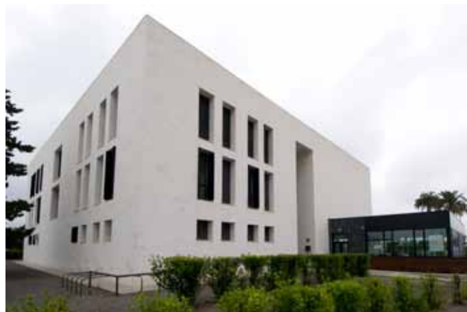
Edificio de Educación Física
