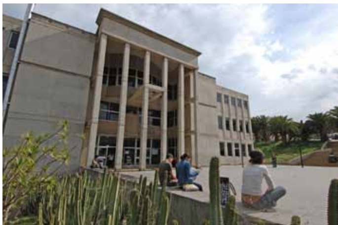
Vista de la fachada del Edificio de Arquitectura
