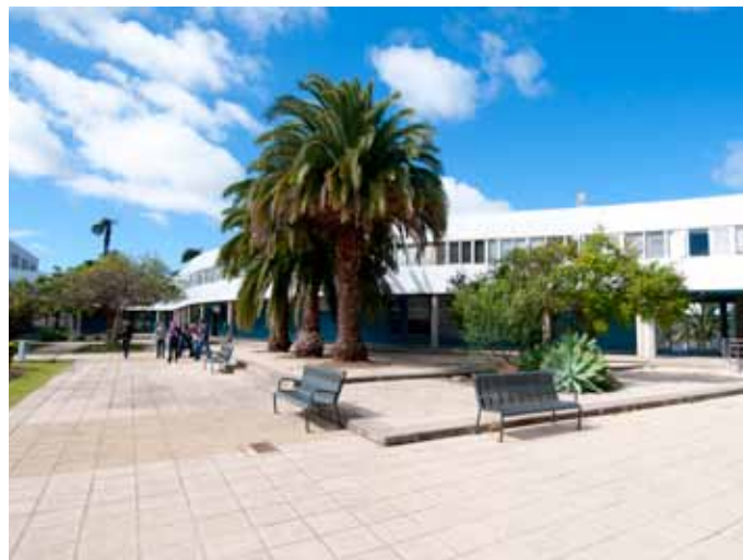
Interior del Edificio de Ingenierías en el Campus Universitario de Tafira
