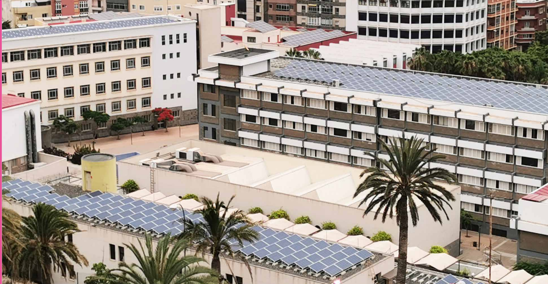
Placas solares en el Campus del Obelisco
