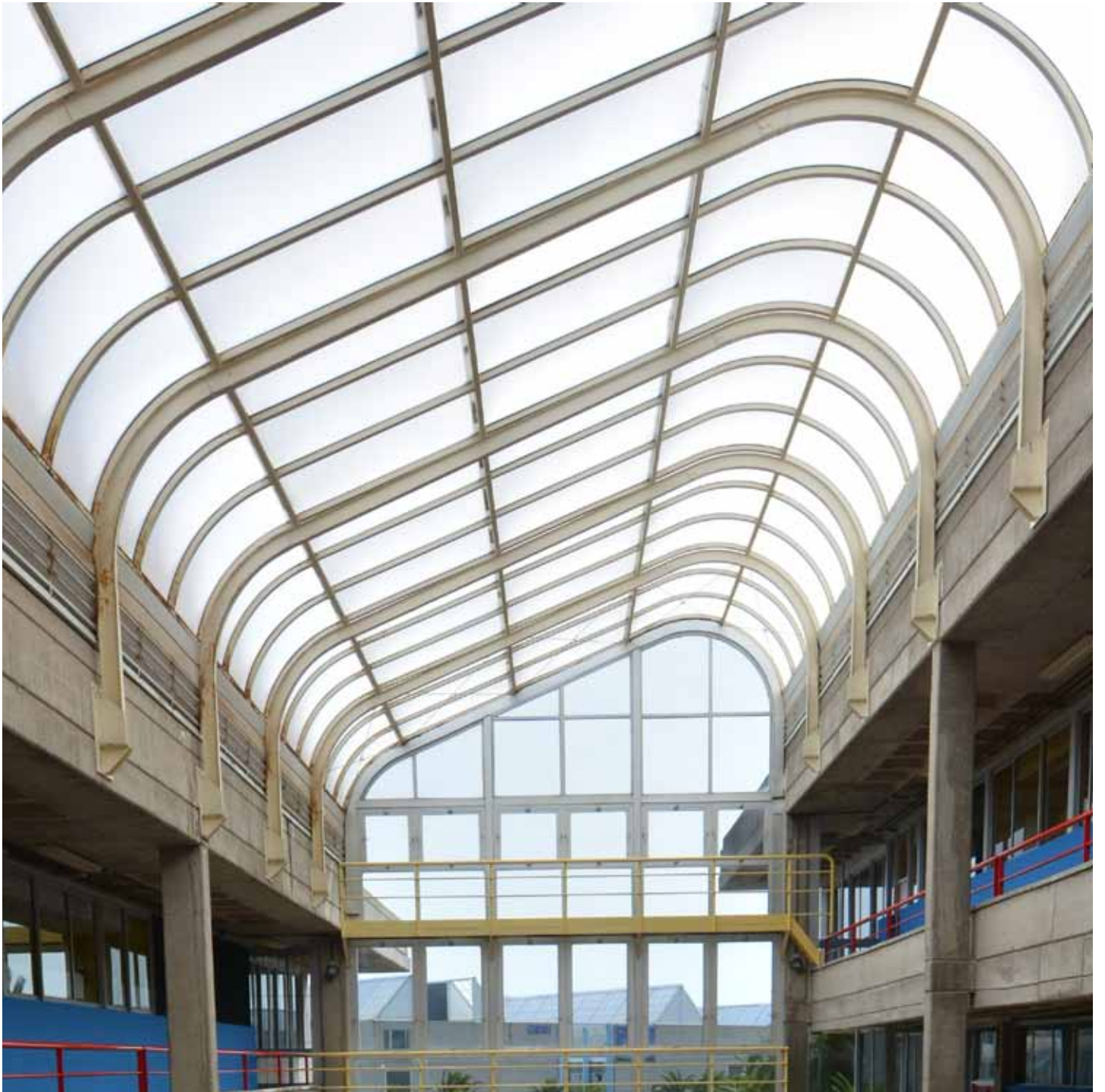
Interior del Edificio de Arquitectura
