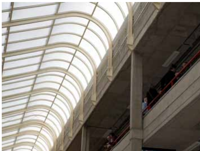
Interior del Edificio de Arquitectura
