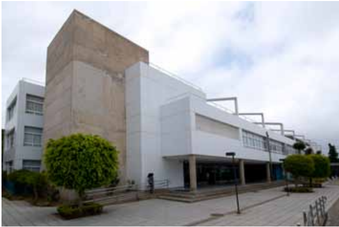
Exterior del Edificio de Ingenierías
