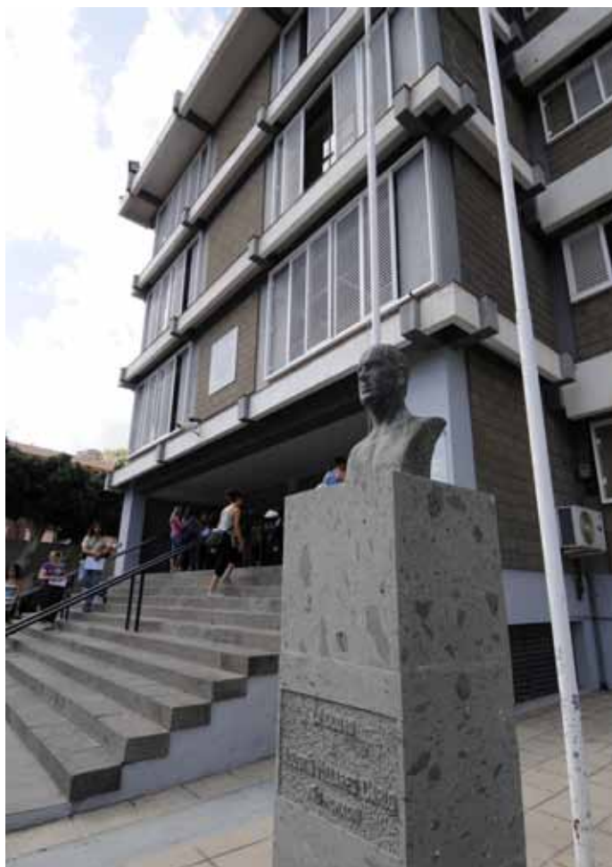
Entrada del Edificio de Humanidades
