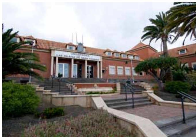
Edificio de La Granja, sede del Servicio de Inspección
