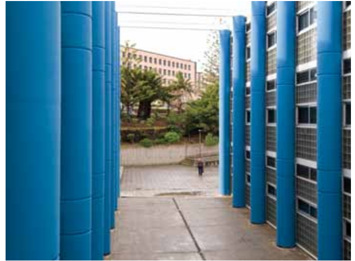
Exterior del Edificio de Informática
